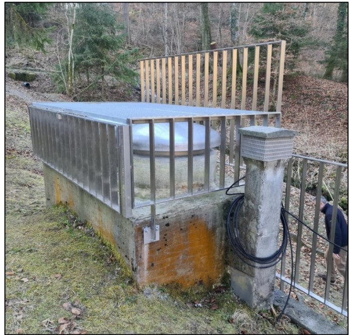
Barrière de protection Pont-neuf
