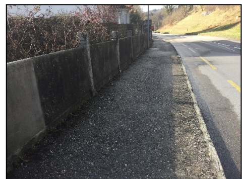
Trottoir route de la Glâne avant travaux
