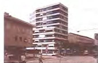
SITUATION D'ANGLE - BATIMENT ADMINISTRATIF
