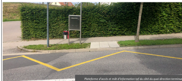
Plateforme d'accès et mât d'information tpf du côté du quai direction terminus
