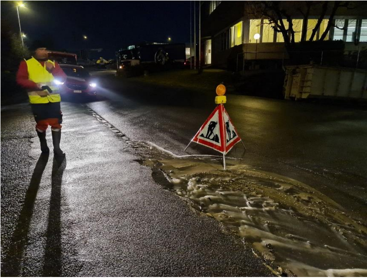
1a. Signalement d'un dégât d'eau sur la route du Petit-Moncor
