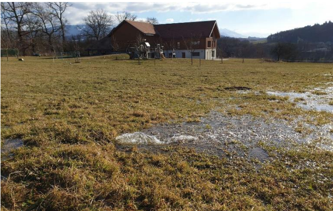
2a. Signalement d'un dégât d'eau dans un champ
