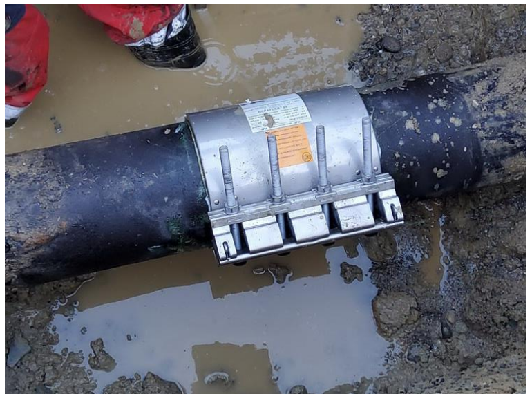
1d. Réparation à l'aide d'un manchon
