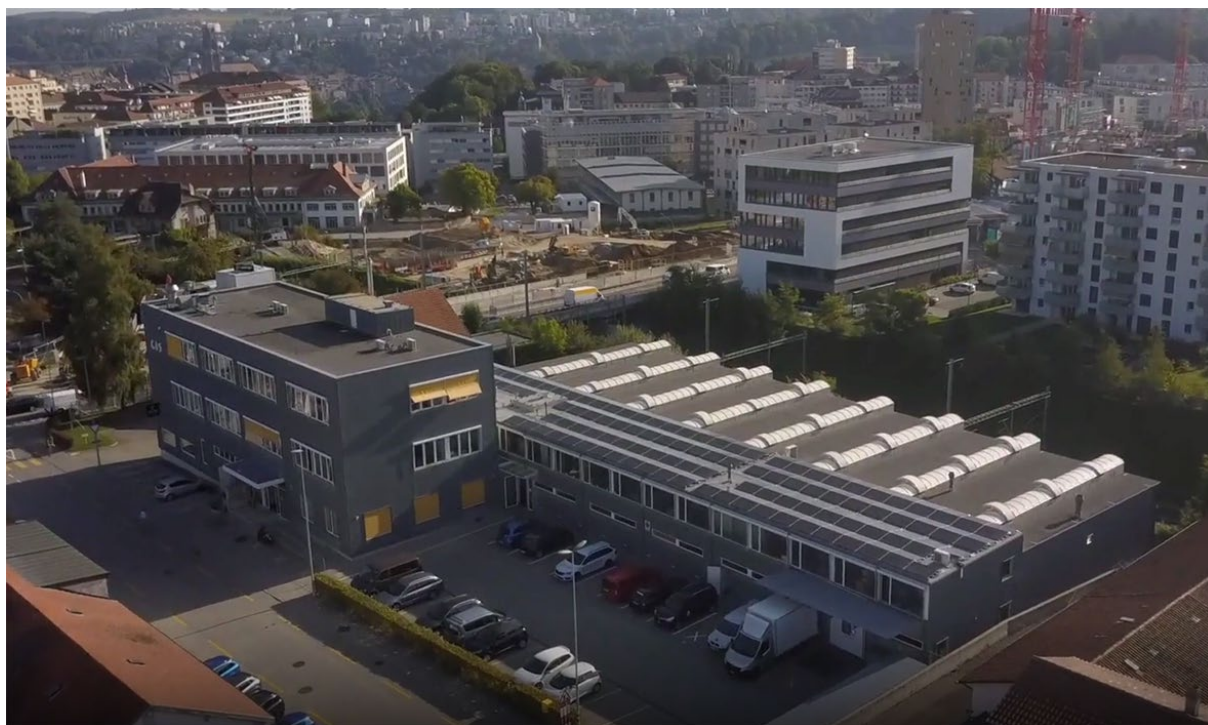
Le bâtiment de la route des Daillettes 1. Source : www.cisf.ch
